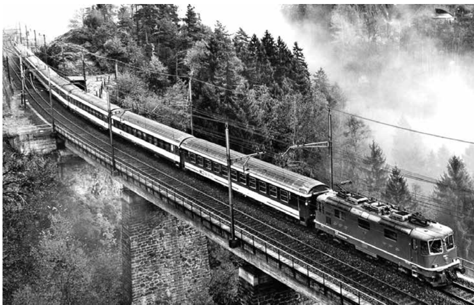
Fig. 2 – Zraggentalbrücke, fotografia di Adriano Heitmann (2018)
